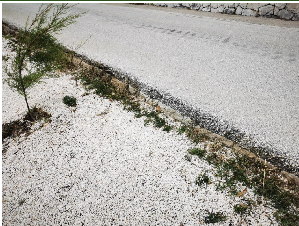
Fotografija 1-3: Postojeći obalni zid na plaži
